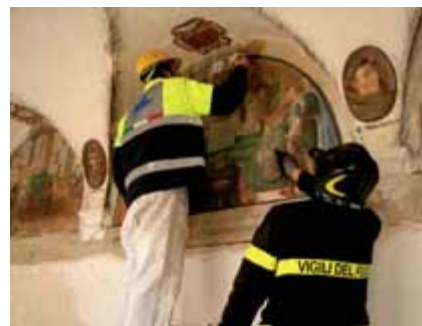
7 Fig. 7 - Collaborazione con i Vigili del Fuoco durante le fasi di pronto intervento di velatura con Paraloid® ed acetone.
