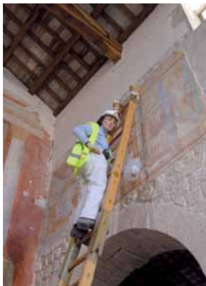
6 Fig. 6 - Prima fase di messa in sicurezza su dipinti murali.
