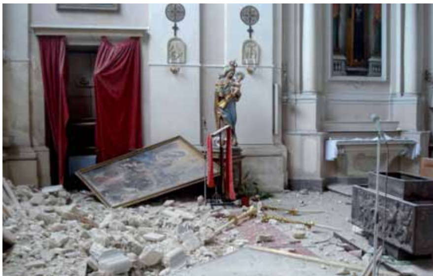
Fig. 3 - Primo sopralluogo utile per definire le modalità d'intervento.
