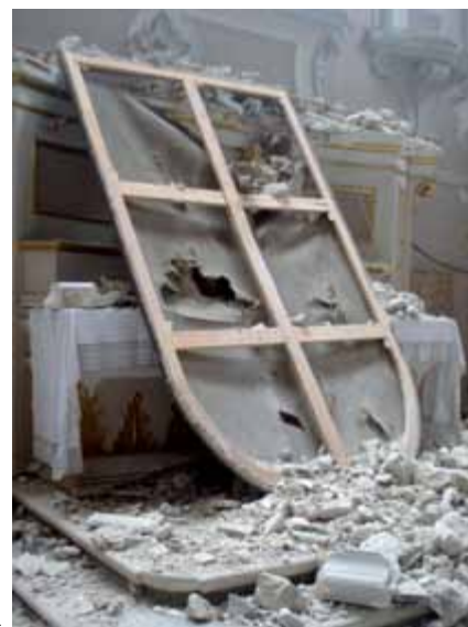
Fig. 4 - Dal sopralluogo si pianifica il recupero delle opere mobili.
